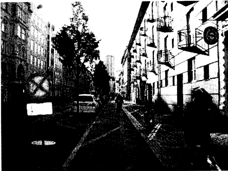
Tasoerotettu kaksisuuntainen pyörätie (Kuva: Rob Burchfield)
