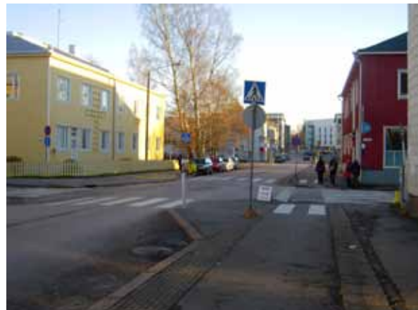
Kuva: Tarpeeton pyörätie? Liittymässä huonot näkemät ja kadulla alhaiset nopeudet. Pyörätie tehty jatkuvuuden perusteella
