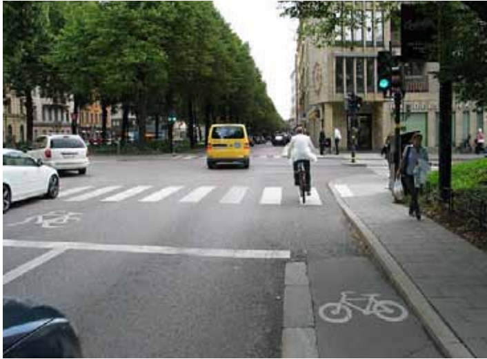
Kuva: Pyörätie lasketaan ennen liittymää ajoradalle pyörätaskuun (Kaupunkifillari)
