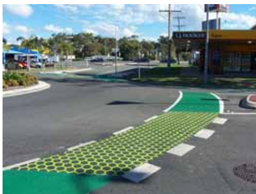
Kuva: Street print- menetelmällä tehty pyöräkaista Australiassa. (Street Print)
